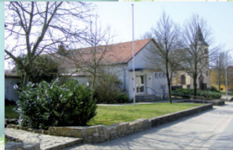
Fürweiler: Renovierung Dorfgemeinschaftshaus
