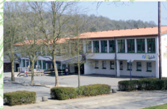
Hemmersdorf: Sanierungsmaßnahmen an der Nidschule
