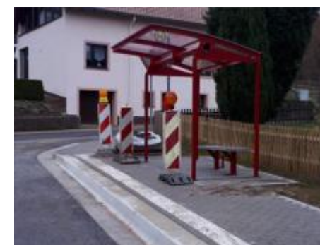
Neugestaltung des Buswendeplatzes
