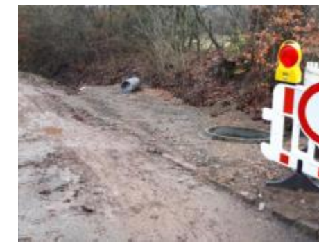
Straßen- und Rinnenausbesserungen in verschiedenen Ortsstraßen (wird kontinuierlich weitergeführt)
