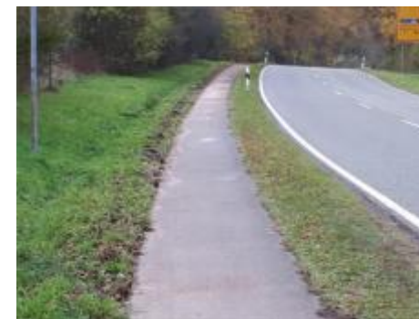
Rekonstruktion des Fahrradweges entlang der L147 Gommshütte Mariahütte
