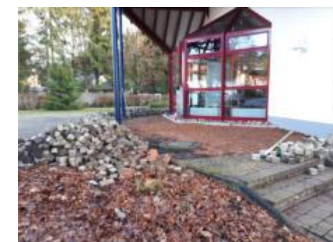
Behindertengerechter Zugang des Bürgerhauses
