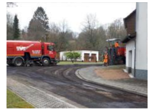
Verschiedene Unwetter-Sicherungsmaßnahmen: Ende Haydnstraße, Brücke Münzbach, Bühlrech (weitere in Planung)
